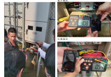
中繼機房接地電阻驗測
